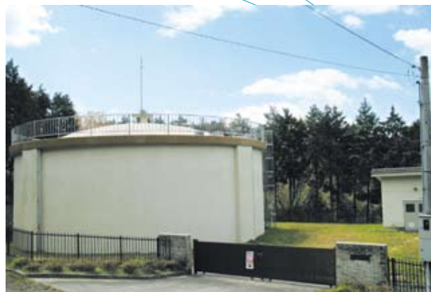
▲第2高区配水池
