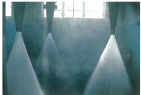
▲浄水池（鯉江）エアレーション
