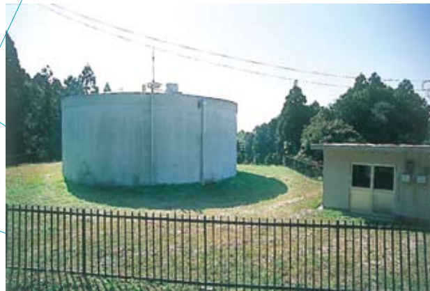
▲第1高区配水池
